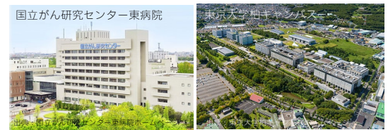
図 1-3 対象区域内の主な施設
