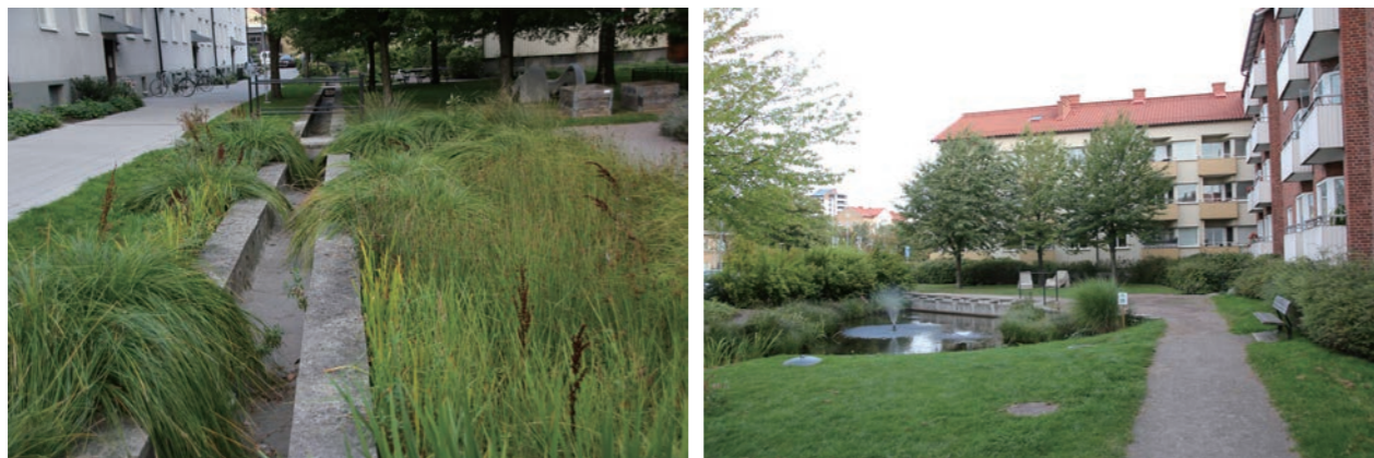
敷地内の雨水処理施設をランドスケープに活用した例 (EKOSTADEN (Augustenborg, Sweden))
