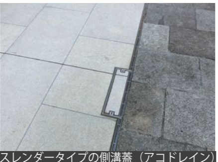
スレンダータイプの側溝蓋（アコドレイン）
