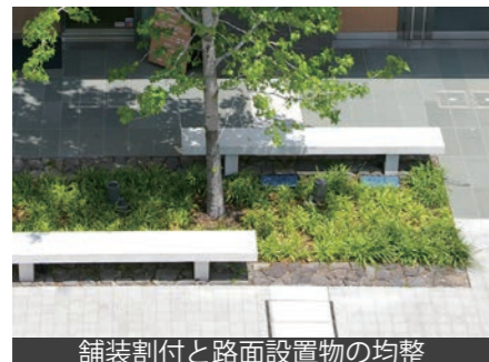
舗装割付と路面設置物の均整
