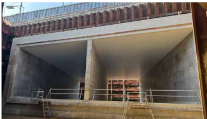
▲都市軸道路 国道16号アンダーパス工事の状況 (2023.3)
