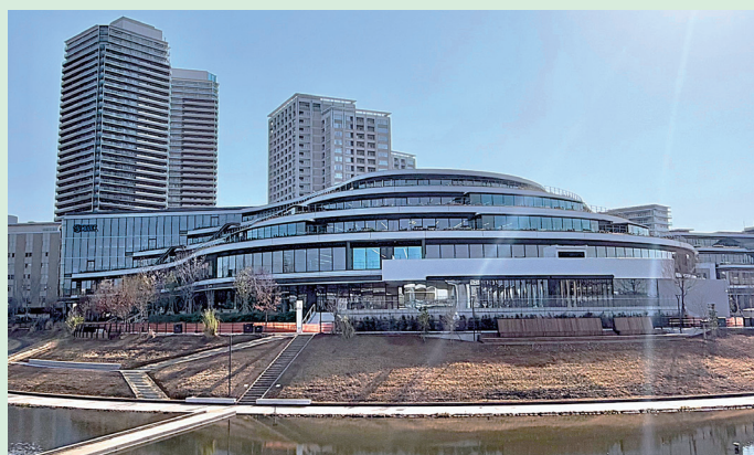
▲SMC Japan Technical Centerの竣工とアクアテラスリニューアル
